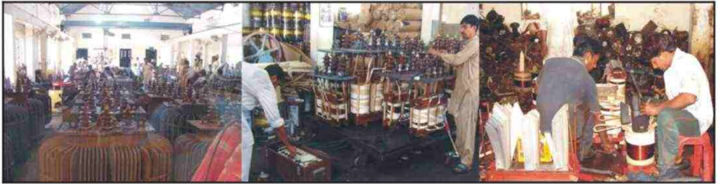
ٹرانسفارمرز ری کلیمیشن ورکشاپ کا عملہ ٹرانسفارمرز مرمت کر رہا ہے۔
